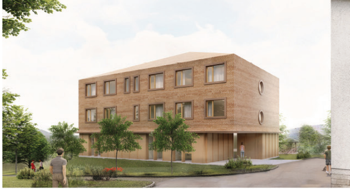
Vue de la nouvelle unité depuis la cour
